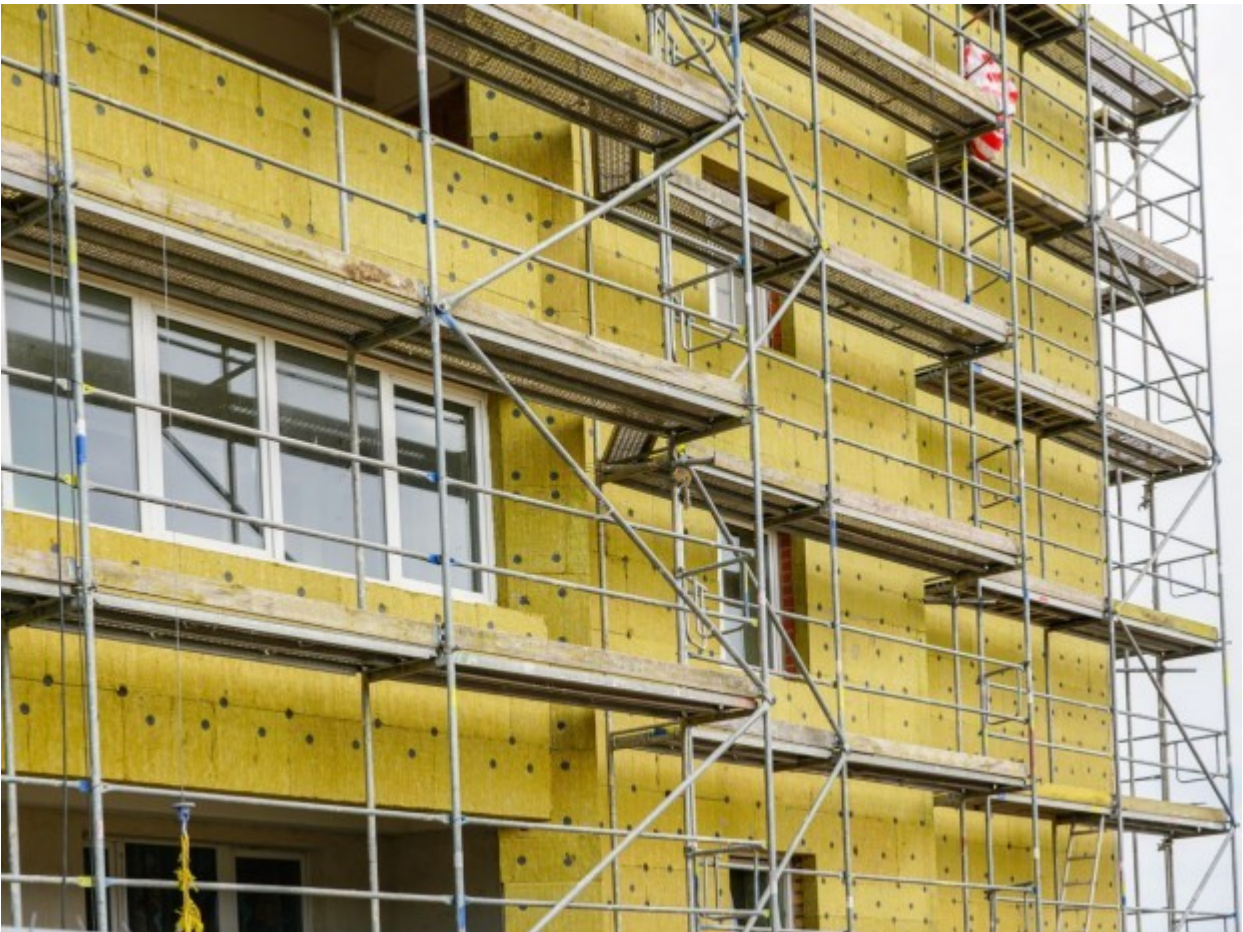
Rénovation énergétique isolation © iStock
